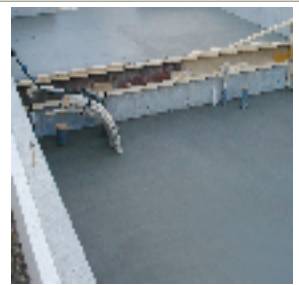
8 コンクリート打設
