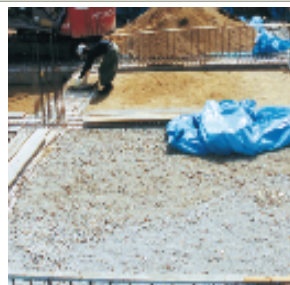
6 砂・碎石 埋め戻し
