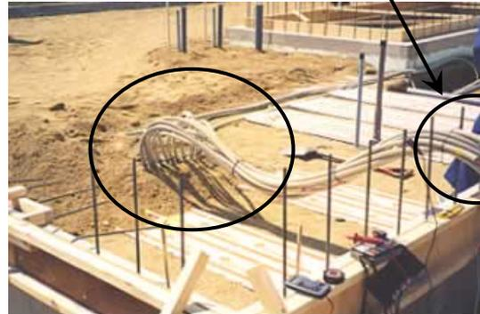
3. 保護砂の上にさらに砕石等をかぶせ、施工完了後しっかりと、プレートで転圧。この後に防湿シートを敷きつめ、回路毎に抵抗値の測定、絶縁チェックをし、検査結果をFAXにて連絡。
