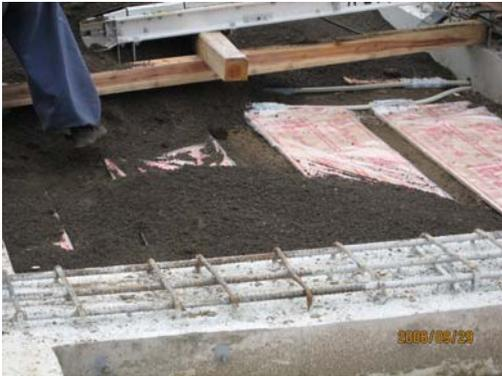
2. 埋め戻し前に、コントローラまたは制御盤の位置にPFS管を立ち上げる。
