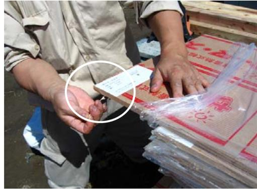
3. 必ずパネル一枚一枚の導通テストを行う。 4. パネルを損傷しないよう石等を除去。
