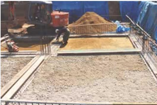
4. 床センサー用PFS管(22φ)を配筋に結び付ける。PFS管の先端はシリコンでしっかり密閉。センサーはコントローラまたは制御盤取付け時に差し込む。(ダブル配筋の例) (注)シングル配筋の場合には、配筋の上に乗せて配筋に結び付ける。
