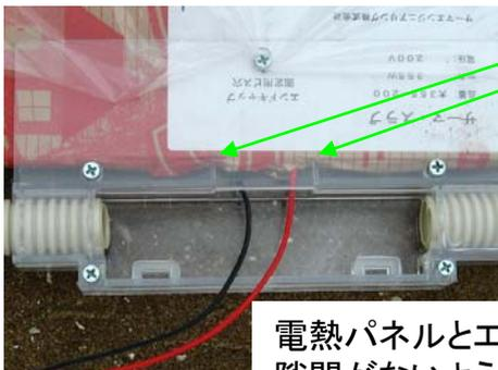
電熱パネルとエンドキャップに隙間がないように固定する
