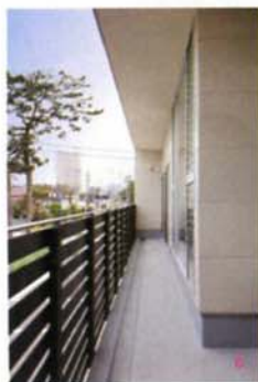
6.南面の庇の奥行きは約90cm。敷地ならではの日当たりを考慮し、夏は日の高い時間の直射日光を遮り、冬は採光を妨げないサイズに設定した
