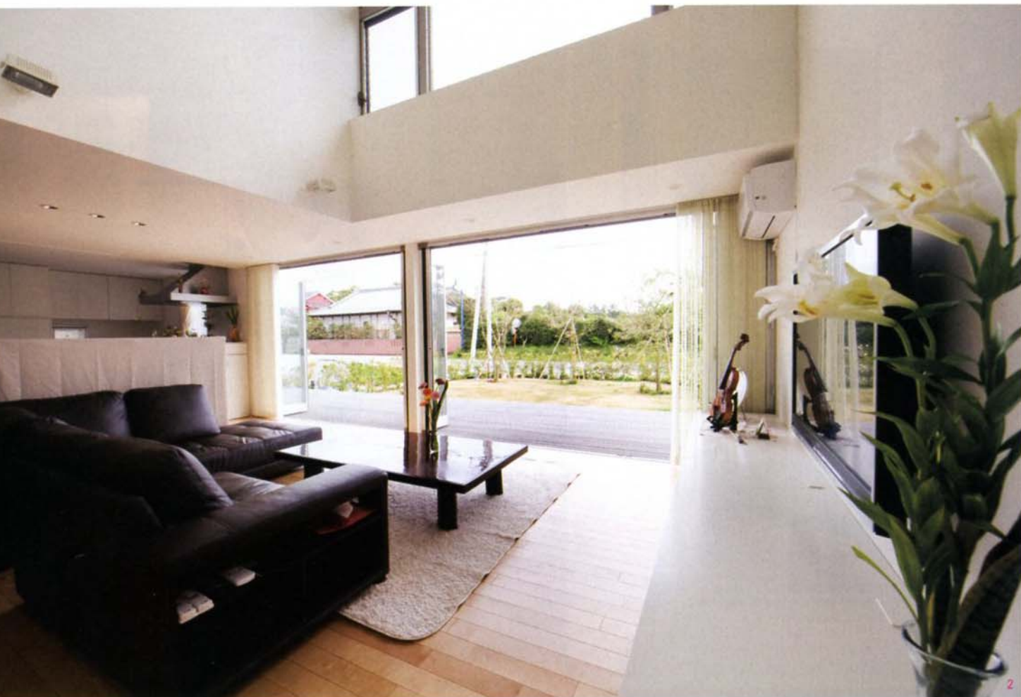
2.リビングとデッキに一体感をもたらすフルオープンサッシ。空気層12mmの複層ガラスを用い、窓に近寄っても体感温度はほとんど変わらない
