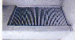
4 電気室と直結した換気口。 電気室に設けられた換気口。
